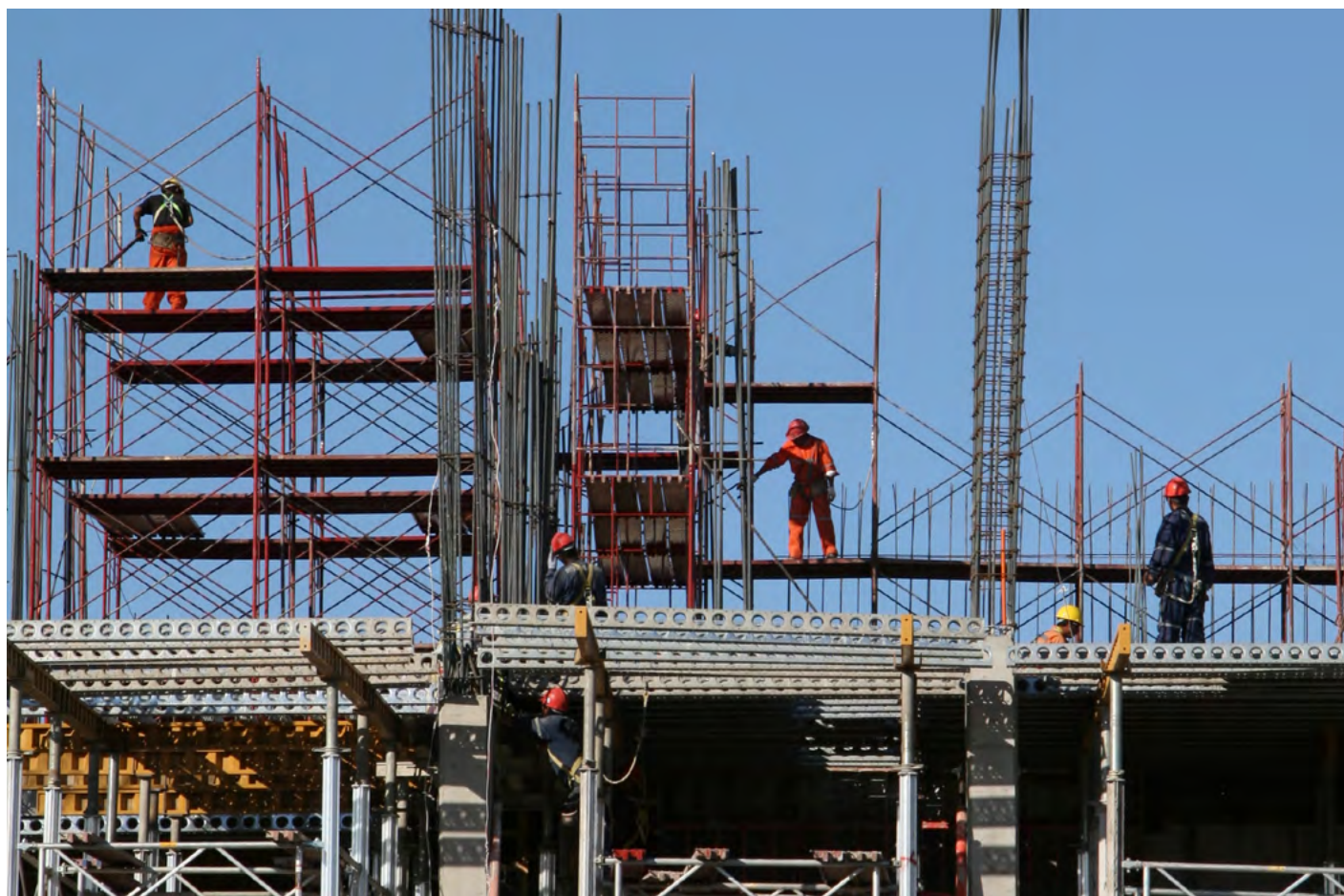
Obras en Valdivia, Chile
